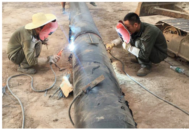
供水管网施工忙
