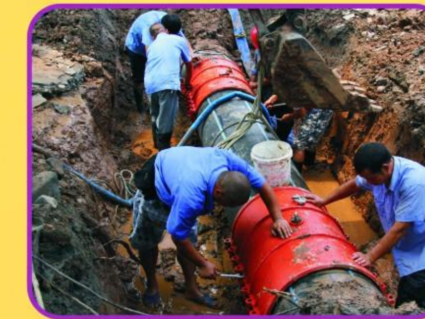
廖子河管网抢修
