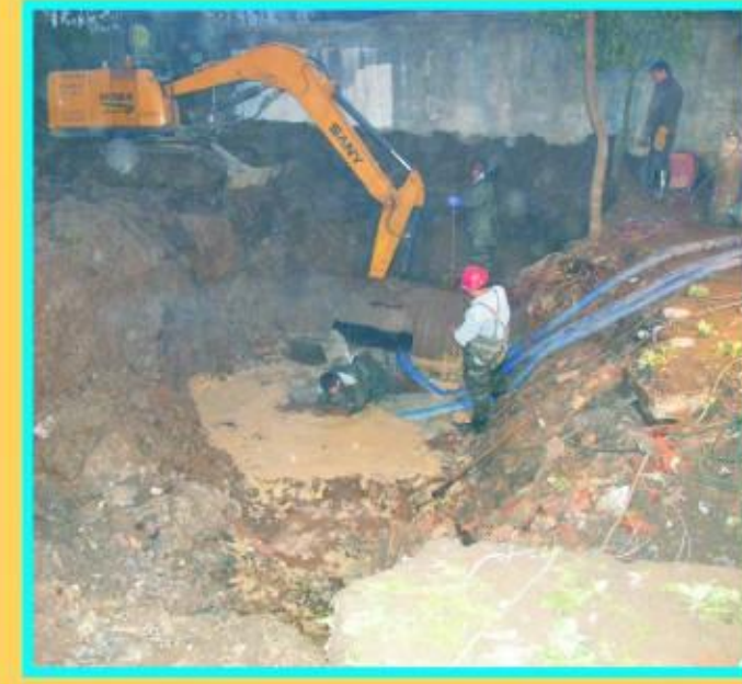
管网抢修现场
